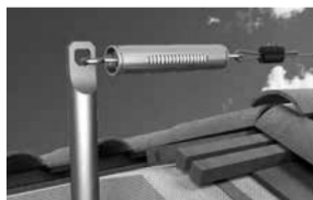
Fune su tetto residenziale
